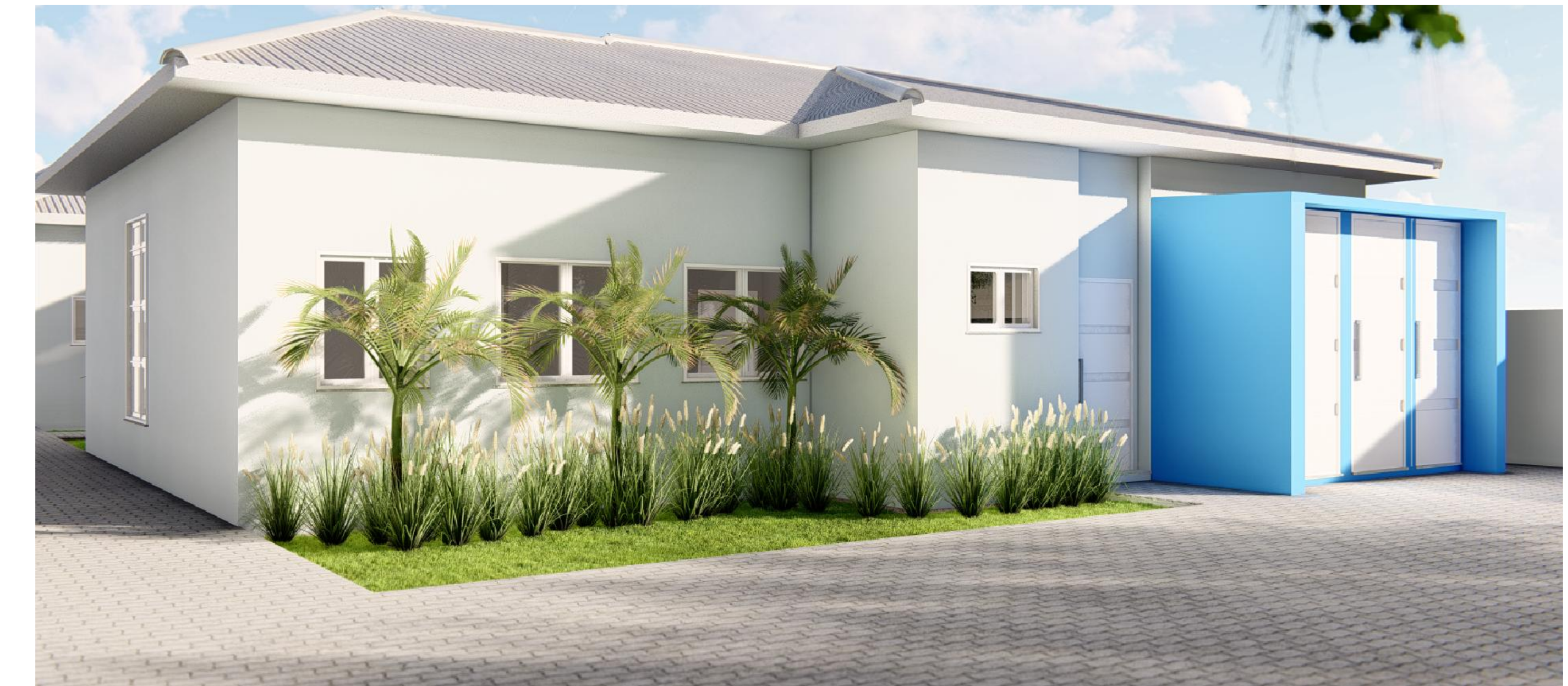
IMAGEM 7 - VISTA DOS FUNDOS DA EDIFICAÇÃO
