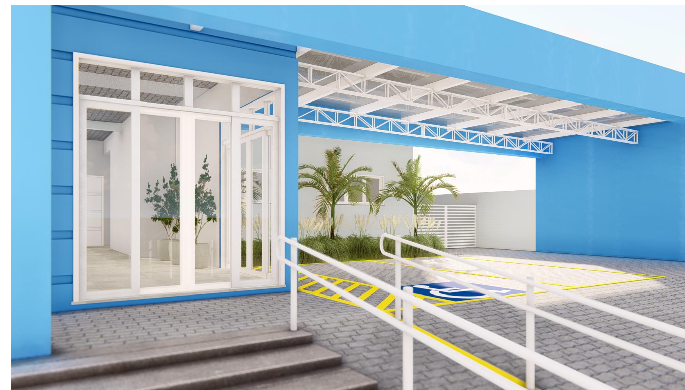
IMAGEM 3 - VISTA1 DA ENTRADA PRINCIPAL E COBERTURA
